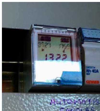
Imagen 45. Reloj astronómico alumbrado exterior
