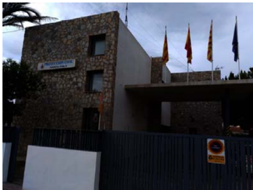
Imagen 18. Fachada de mampostería con piedra natural y fachada con acabado enlucido
