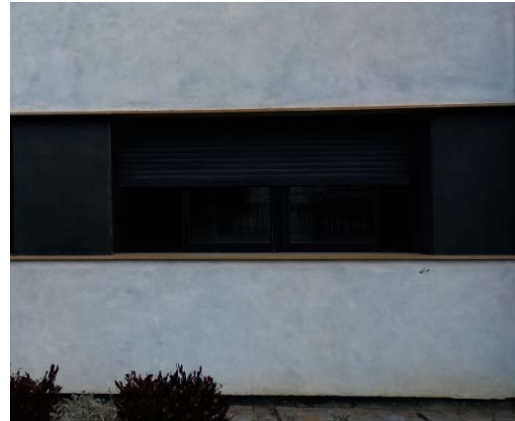
Imagen 19. Carpintería aluminio + vidrio doble - Dispositivo exterior de control solar
