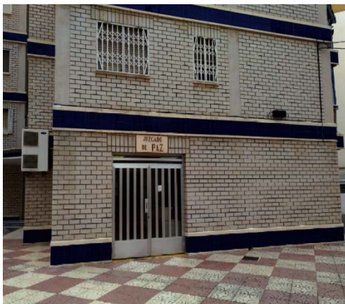
Imagen 9. Fachada de doble hoja con ladrillo caravista edificio oficinas y edificio capilla
