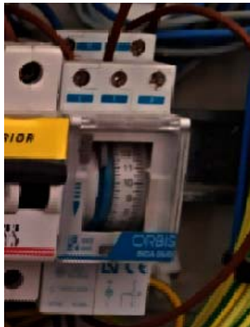
Imagen 62. Reloj convencional alumbrado exterior
