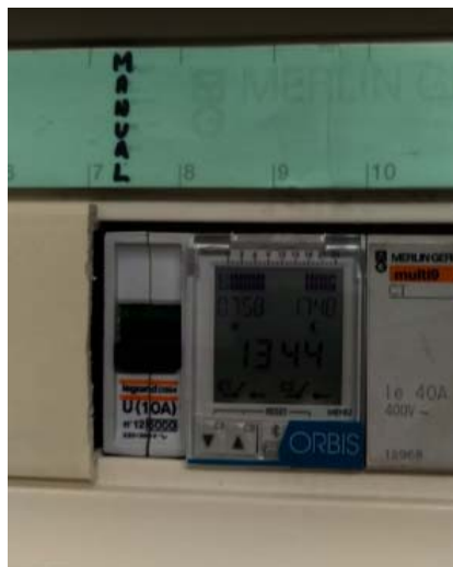
Imagen 56. Reloj astronómico alumbrado exterior
