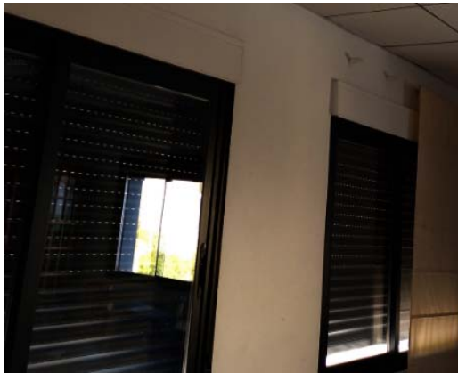
Imagen 19. Carpintería aluminio + vidrio doble - Dispositivo exterior de control solar
