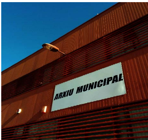
Imagen 12. Fachada de chapa perfilada grecada de acero y enlucido interior
