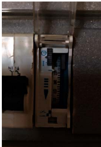
Imagen 28. Reloj convencional alumbrado exterior
