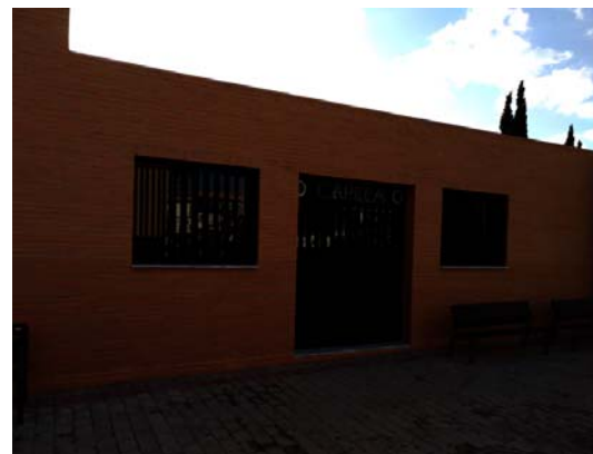
Imagen 3. Fachada de doble hoja con ladrillo caravista edificio oficinas y edificio capilla
