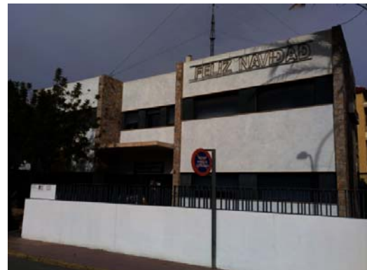
Imagen 18. Fachada de mampostería con piedra natural y fachada con acabado enlucido
