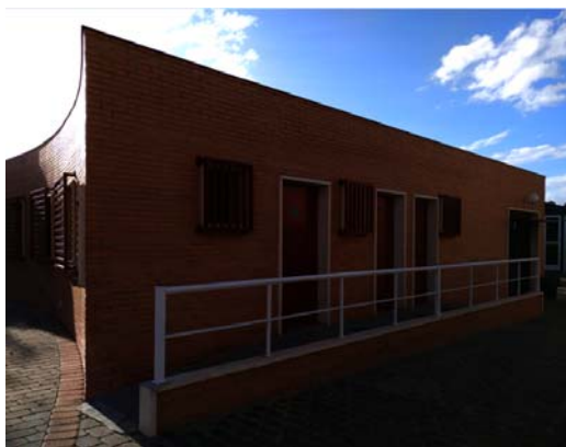
Imagen 3. Fachada de doble hoja con ladrillo caravista edificio oficinas y edificio capilla
